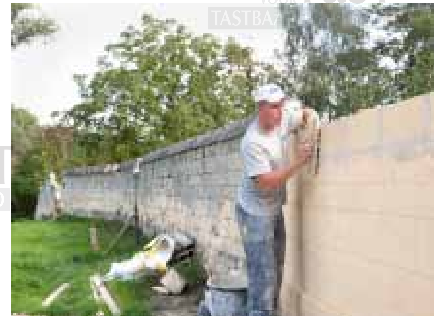
Restauratiewerk aan de in mergel opgetrokken muren van Neercanne in Maastricht.
