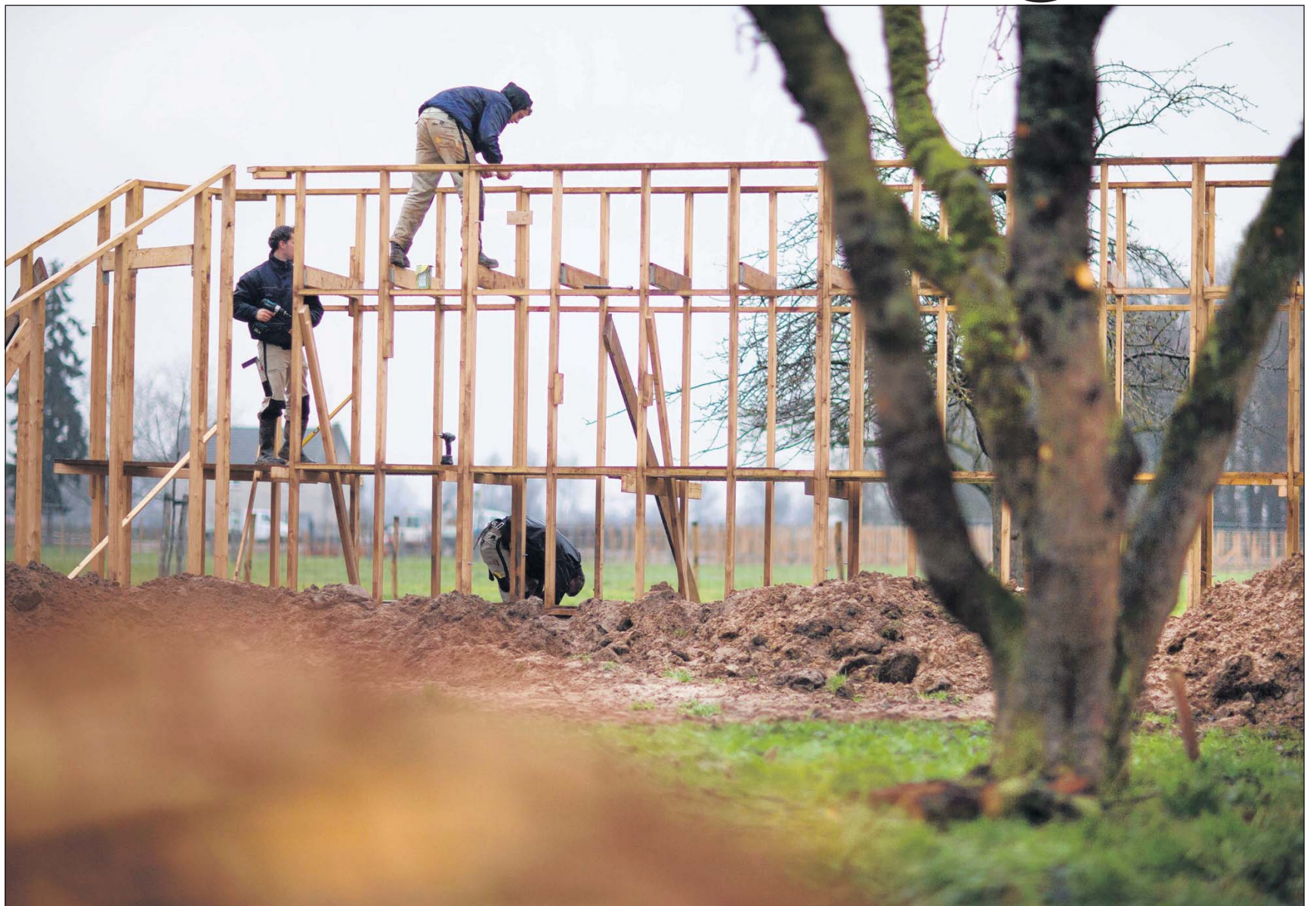
Er wordt al volop gewerkt op het landgoed van kasteel Vaeshartelt.
